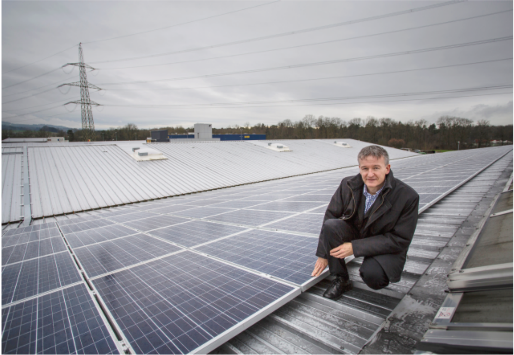
Daniel Gerber auf dem Dach des Lysser KMU-Parks. Seit Mitte Dezember ist hier eine 1700 Quadratmeter grosse Solaranlage in Betrieb.
